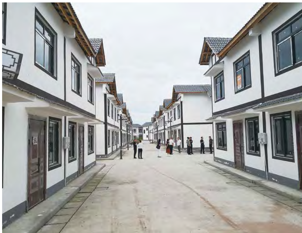
Im Bau: Siedlungszone für die Zusammenfassung der zersplitterten Siedlungsform (2025) 在建：整合碎片化聚落形态的集中居住区（2025）
