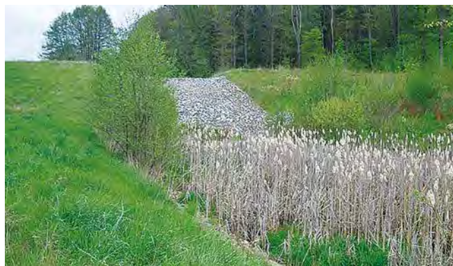
Flood retention basin (picture source Karl Spindler) 雨水调蓄池（图片来源：卡尔·施宾德勒）
