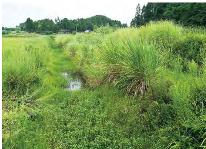
Naturnaher Gewässerausbau (2025) 生态型水域治理（2025）
